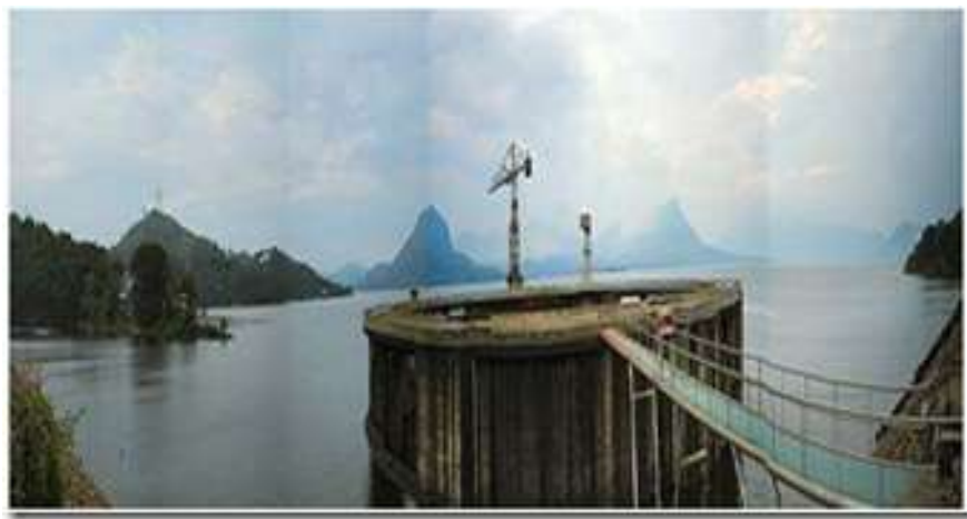
Gambar 22. Bendungan Sebagai Pembangkit Listrik
