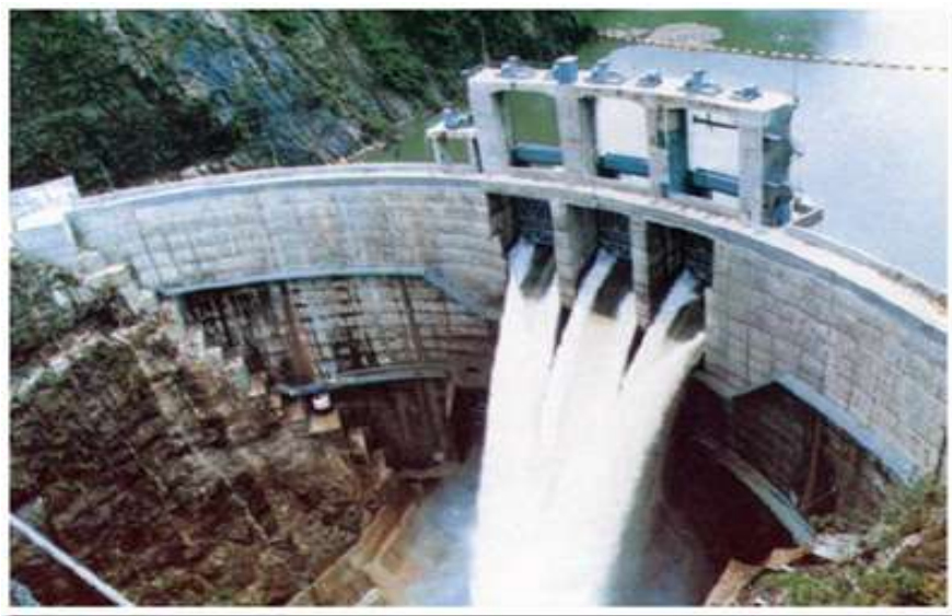
Gambar 15. Bendungan atau dam
