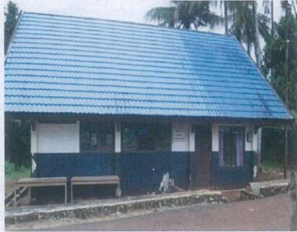
Gambar 4. Bangunan klinik hewan (dokumentasi pribadi)
